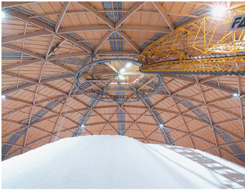
Saldome 2 ist der grösste Holz-Kuppelbau Europas mit einem Fassungsvermögen von rund 100'000 Tonnen losem Salz.
